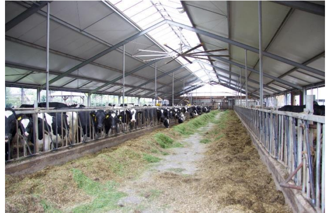
Afbeelding 2- HVLS ventilator in koeienstal
