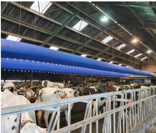
Afbeelding 3- Buisventilatie melkveestal
