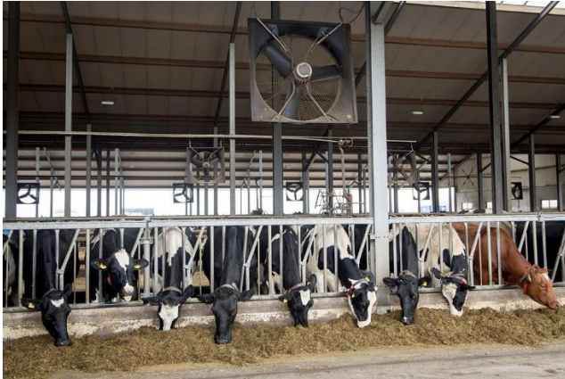
Afbeelding 1- Dwarsventilatie in koeienstal
